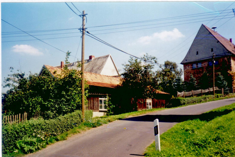
ehemaliges Sägewerk der Vorwerksmühle
