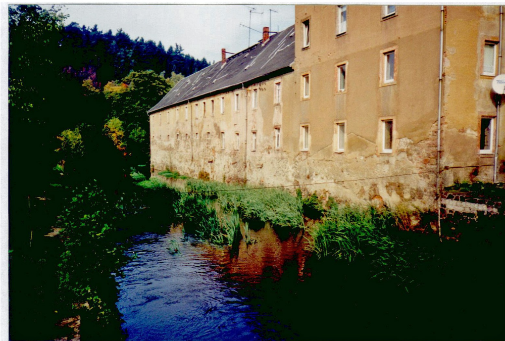
Liebenhainer Mühle Wohnhaus vom Mühlgraben aus
