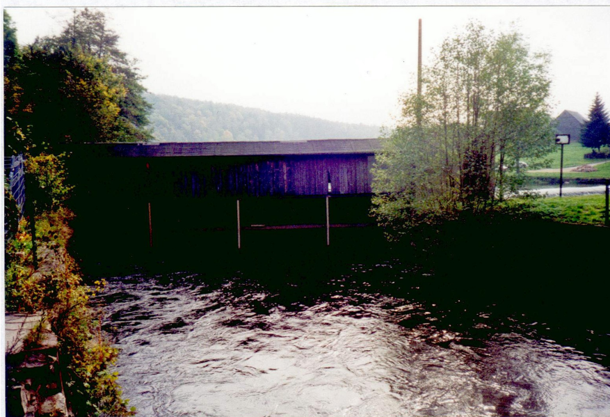
Liebenhainer Mühle altes Wehr
