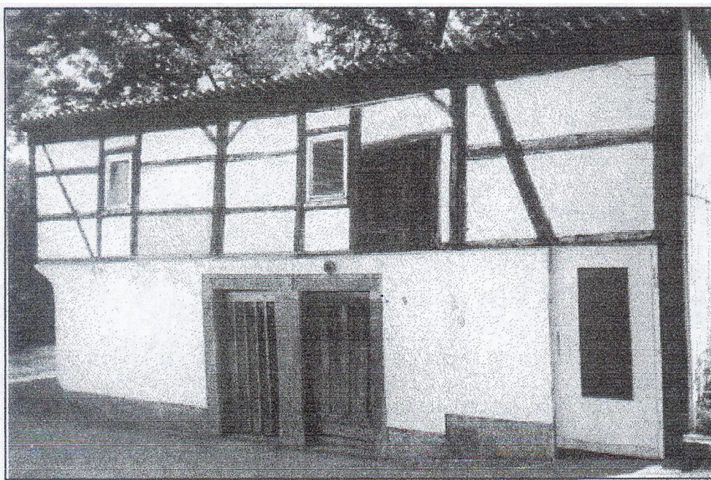
Wirtschaftsgebäude Blühermühle Topfseifersdorf, 2000
