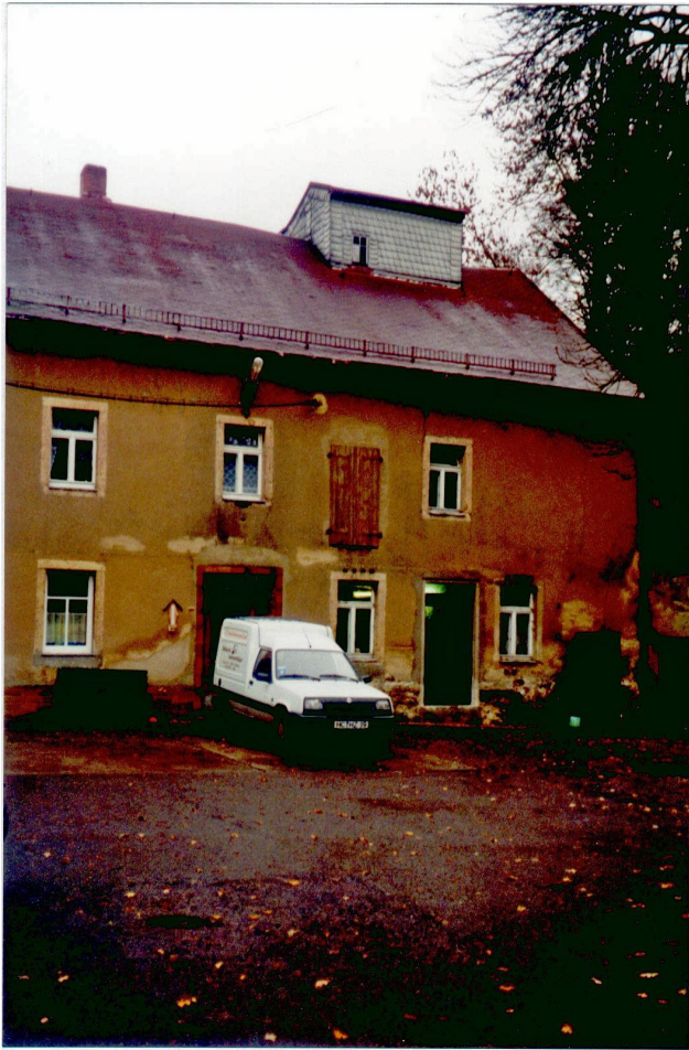
ehemaliges Mühlengebäude der Schlegeler Mühle
