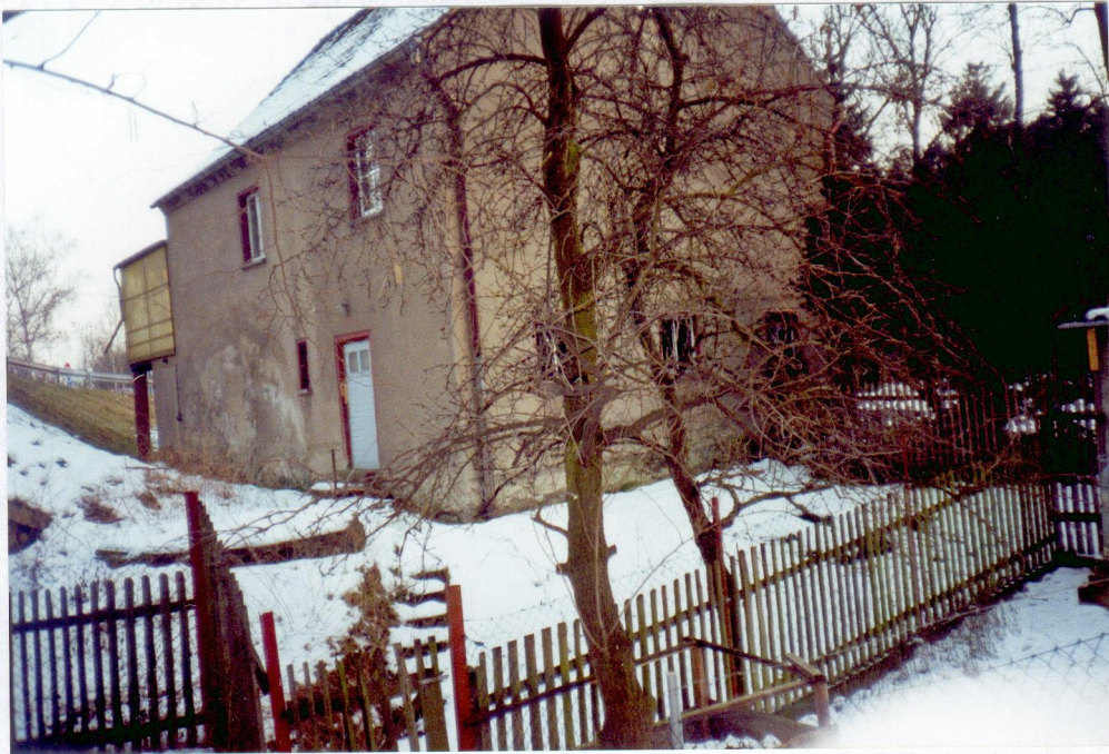
ehemalige Mühle beim Scheibengut bis ca. 1997 Wohnhaus der Fam. Richter heute steht das Haus leer
