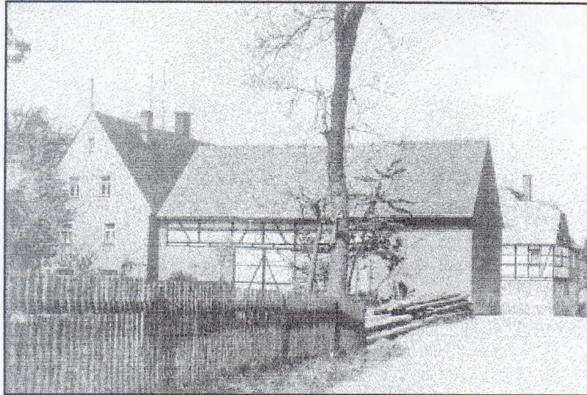
Obermühle Rossau, Nordost Ansicht von 1959
