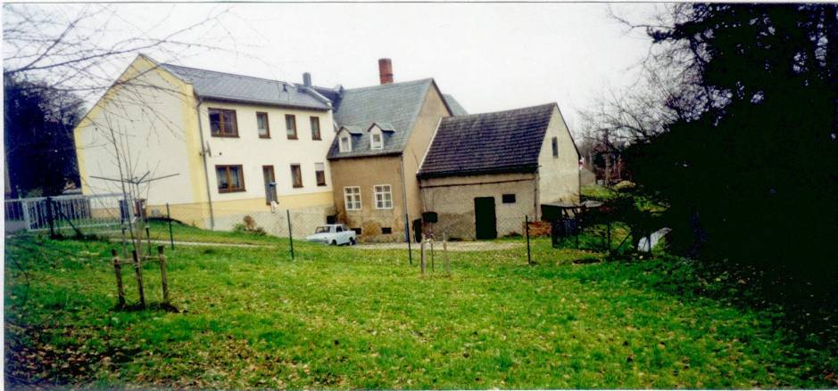
ehemalige Schenkelmühle jetzt Wohnhaus
