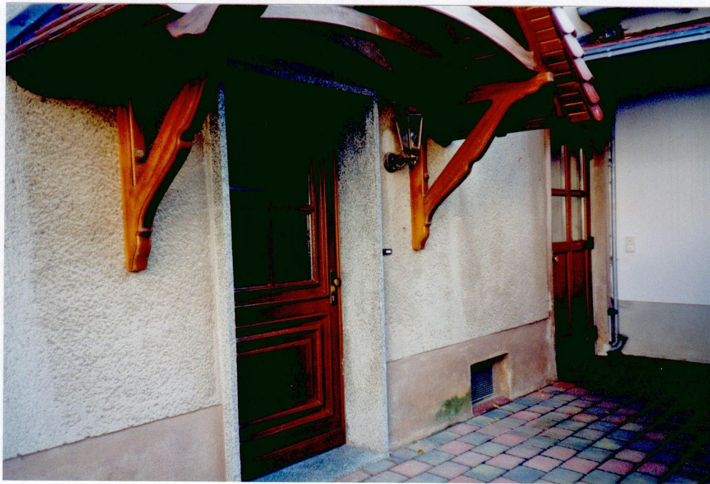
ehemalige Eingangstür links rechts ehemaliger Mühleneingang
