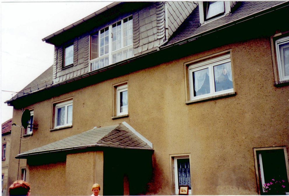
Wohnhaus mit ehemaliger Mühle
