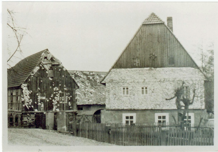
Westansicht des Dreiseiten- Mühlenhofes, von der Dorfstr. aus, rechts: Mühlen- u. Wohnhaus links: Seitengebäude mit Korn- kammer im OG, parterre: Ställe Hintergrund: Scheune (Sept. 1990)
