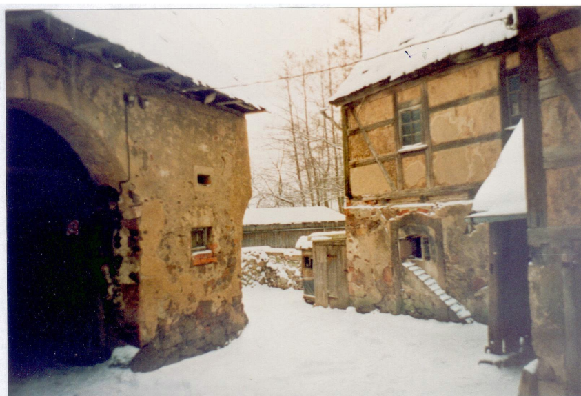
Blick auf den Bäckerei-Anbau, links im Bild südl. Teil der Scheune
