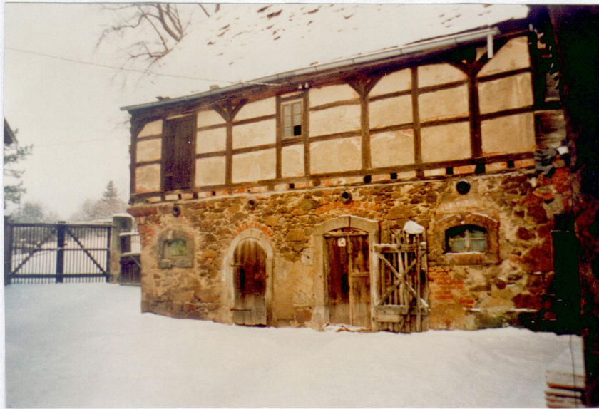
Blick auf das Seitengebäude im nördl. Teil des Grundstückes (Stallung und Kornboden)
