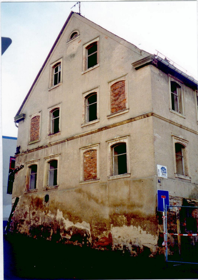
Giebel des Mühlengebäudes
