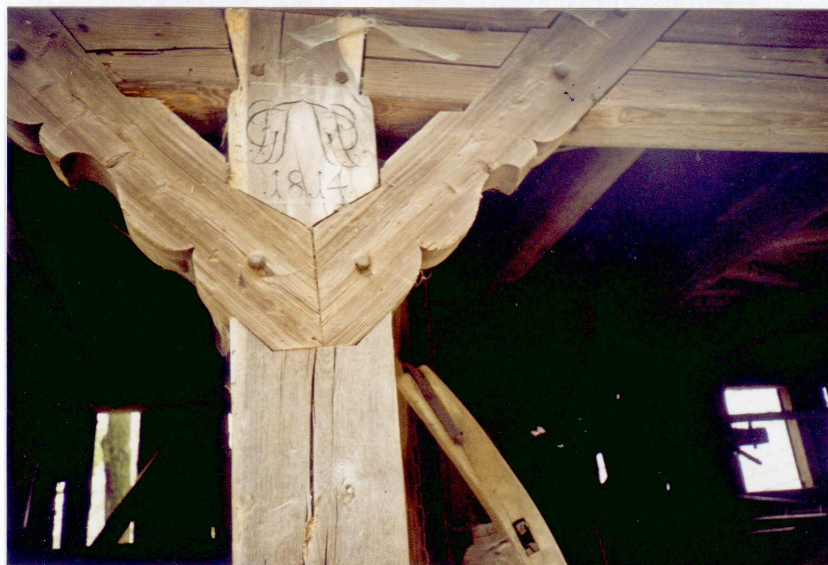
Inschrift am Mittelbalken des ehemaligen Sägewerkes 'C.F.T. 1814'
