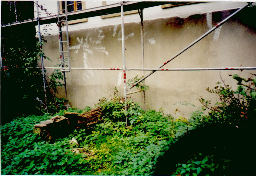
hölzerne Welle am renovierten Mühlenge- bäude der Gopsberger Mühle
