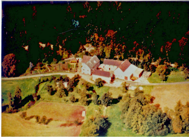
Luftbildaufnahme der Reichenmühle von 1993
