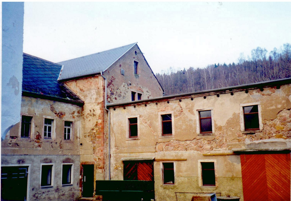
Mühlengebäude mit Nebengelass
