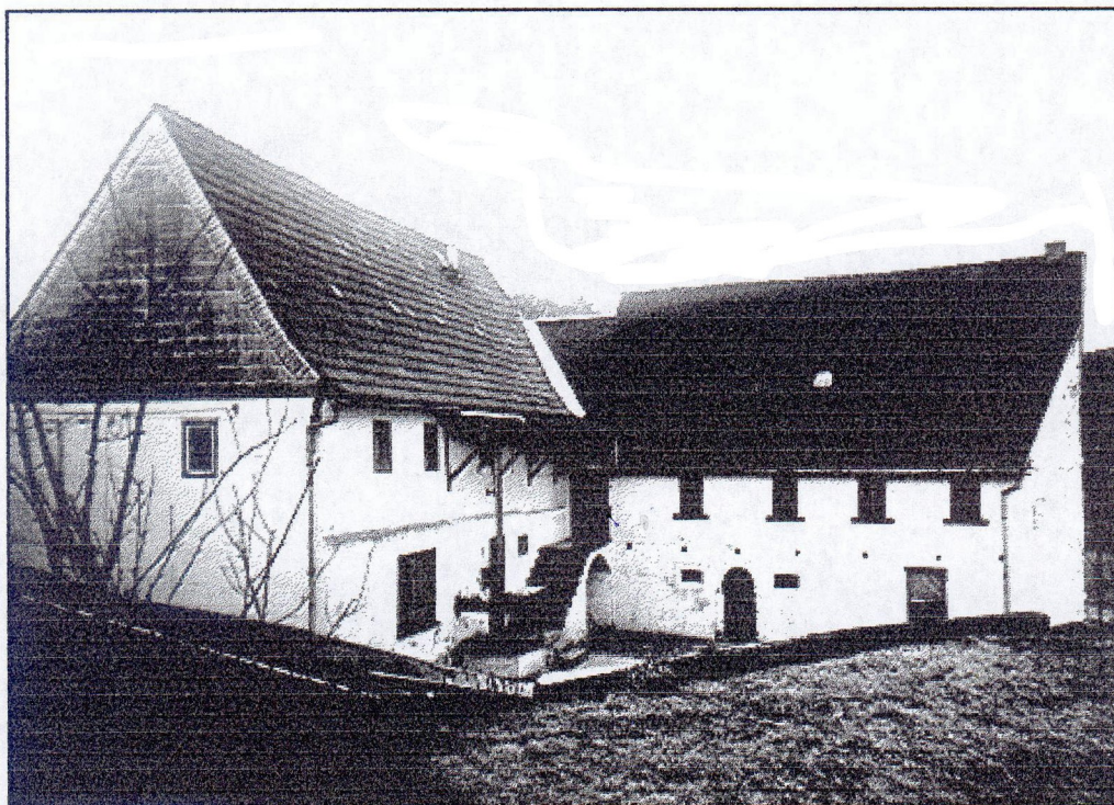
Wirtschafts- und Wohngebäude Untermühle Biesern, 2001
