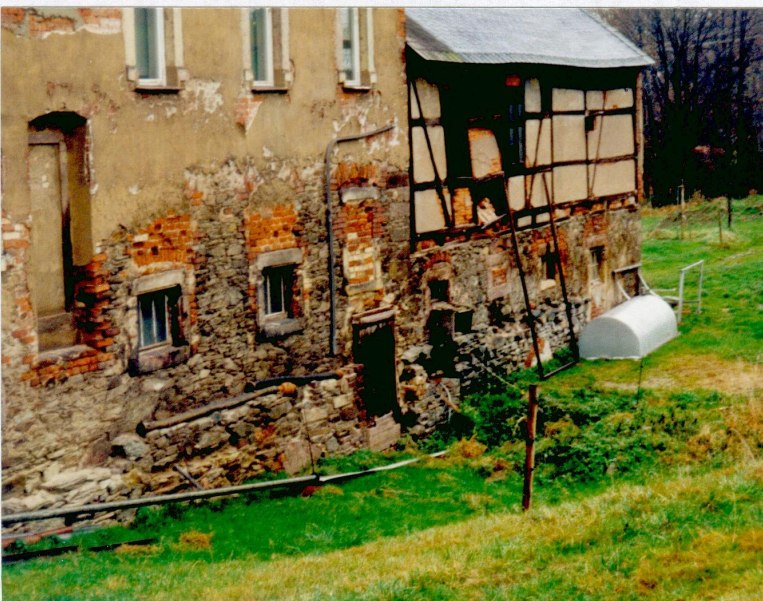
Hinteransicht: Verlauf des ehemaligen Mühlgrabens und Standort des Wasserrades
