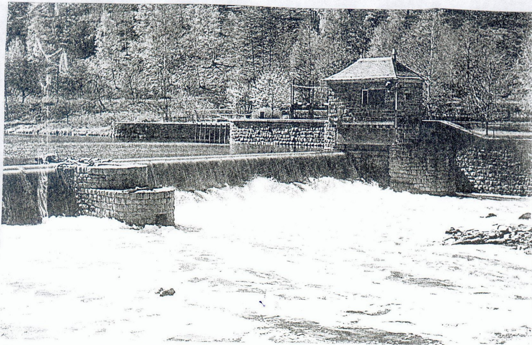
9) Wie fast überall im Muldental bildete die Wasserkraft die Grundlage für die Ansiedlung von Industrieanlagen. Hier die Wehranlage der ehemaligen Papierfabrik "Biebermühle" bei Rochsburg in den 60er Jahren.
