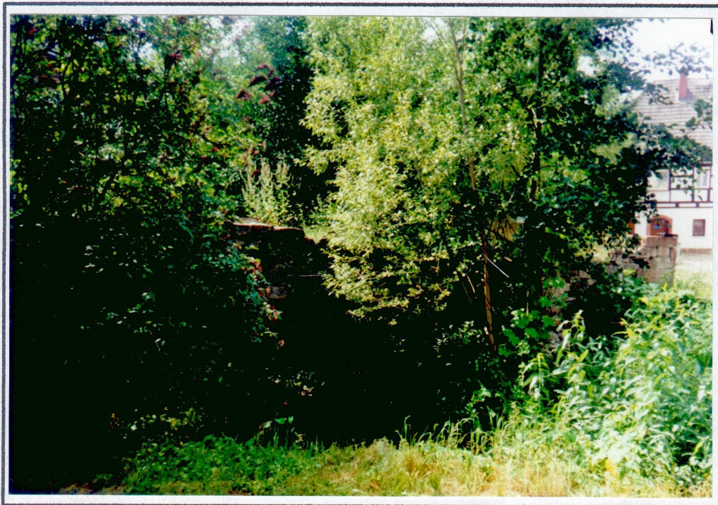
Steinbogenbrücke zur Altzschillener Mühle, 2000
